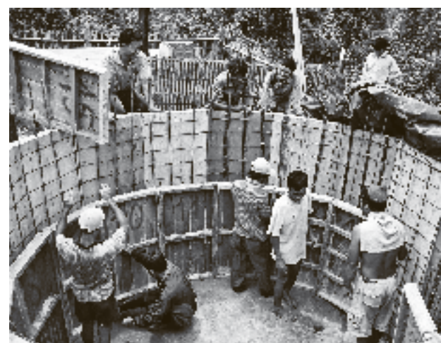
Un equipo de Acción contra el Hambre construye un pozo para así proporcionar acceso al agua en las comunidades rurales
